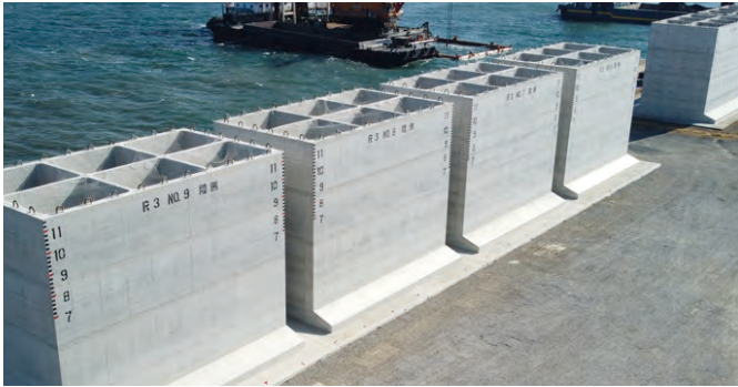
大在西地区ケーソン製作工事（大分県大分市）
