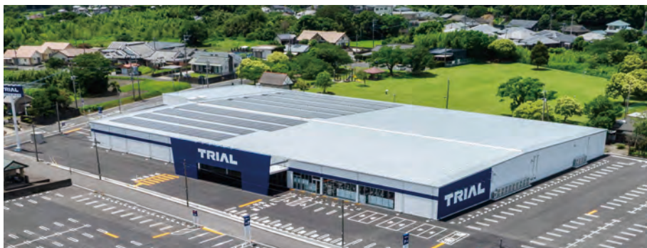
スーパーセンタートライアル鹿屋上野町店(鹿児島県鹿屋市)
