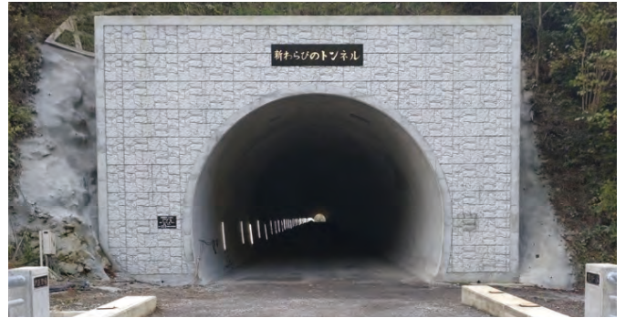
新わらびのトンネル工事（大分県日田市）
