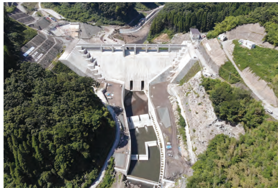
玉来ダム本体建設工事 (大分県竹田市)
