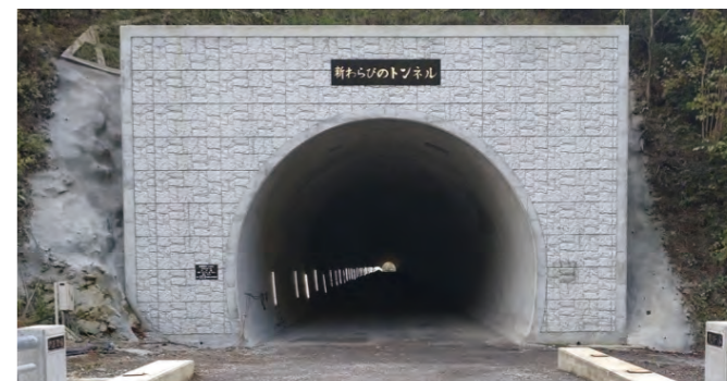
新わらびのトンネル工事 (大分県日田市)
